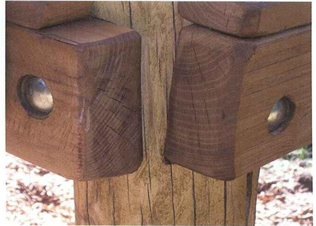
Handwerklich konstruktiver Holzschutz: Die Lage der Hölzer – Kernseite nach oben, so dass die radialen Schwind-/Trockenrisse schräg nach unten verlaufen und keine Wassertaschen bilden können.
