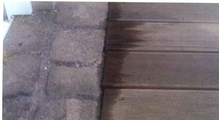
Das werksseitig aufgetragene Versiegelungswachs an den Brettenden muss ausgekapt werden, sonst entstehen später Flecken von einziehendem Wachs.
