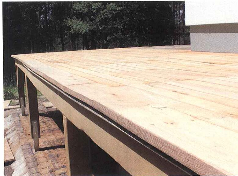
Senkrechte Bauteile wie Stützen, an denen das Wasser schnell ablaufen kann, sind der Gebrauchsklasse 3.1, der waagrecht exponierte Belag ist der Gebrauchsklasse 3.2 zuzuordnen.
