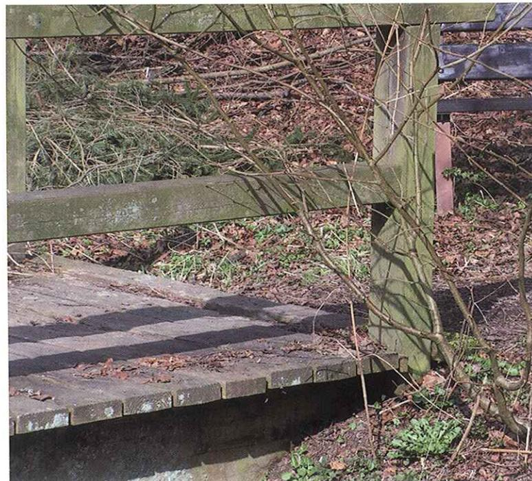
Der Belag ist durch Laub, Schmutz und Erdreich der Gebrauchsklasse 4 nach DIN 68800 Teil 1 ausgesetzt.
