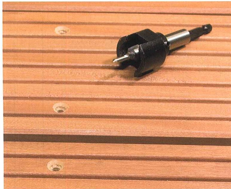
Verschraubung auf den Stegen der Nutenseite – Für eine saubere Verarbeitung empfiehlt sich das Vorbohren mit dem Versenker. Dabei ist der Geometrie des Schraubenkopfes Rechnung zu tragen.
