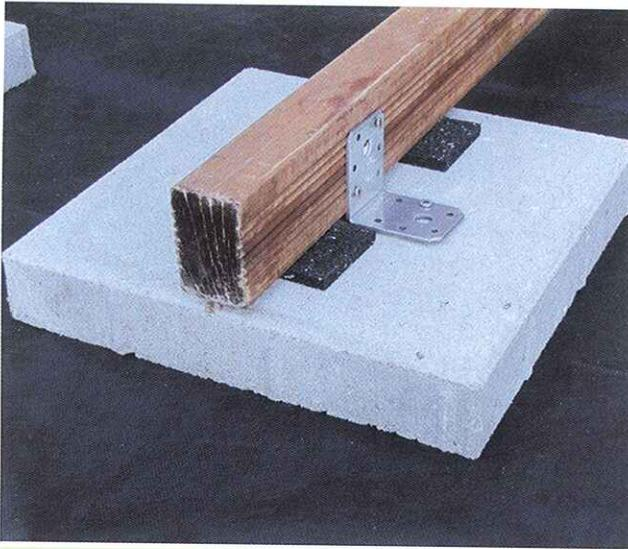
Winkelbefestigung der Unterkonstruktion 42 mm x 70 mm auf einer Gehwegplatte mit wasserundurchlässigen Unterlegpads.
