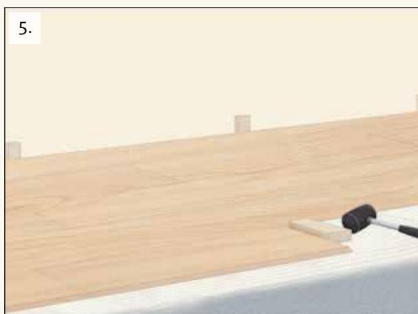
5. Wenn nötig, die kopfseitige Fuge unter Einsatz eines Schlagklotzes schließen.
